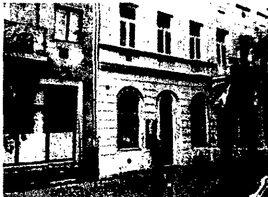
02. utcai homlokzat, üzlethelyiség bejárata
