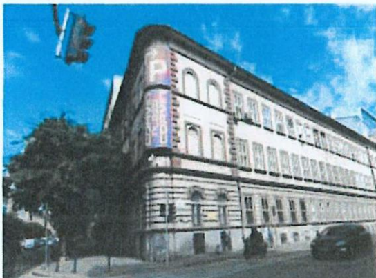
03. épület utcai homlokzat
