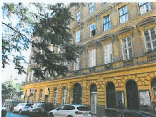
03. épület utcai homlokzata
