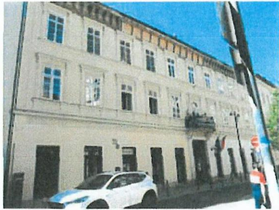
01. utcakép, utcai homlokzat
