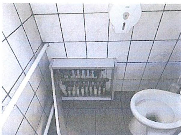
12. WC, fűtésrendszer osztóvezetékei
