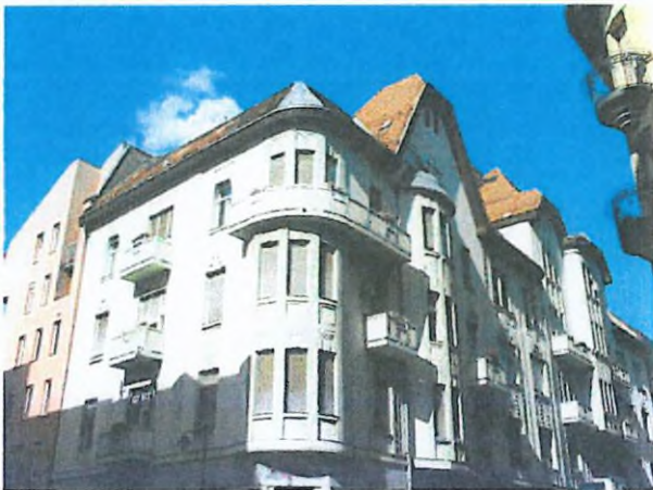
02. utcafronti homlokzat, tetőszerkezet
