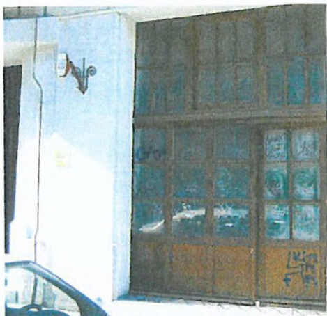
06. homlokzat, lábazat, üzlet bejárata
