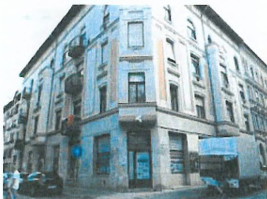
03. épület utcai homlokzata
