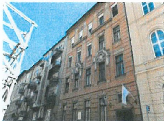
03. épület utcai homlokzata
