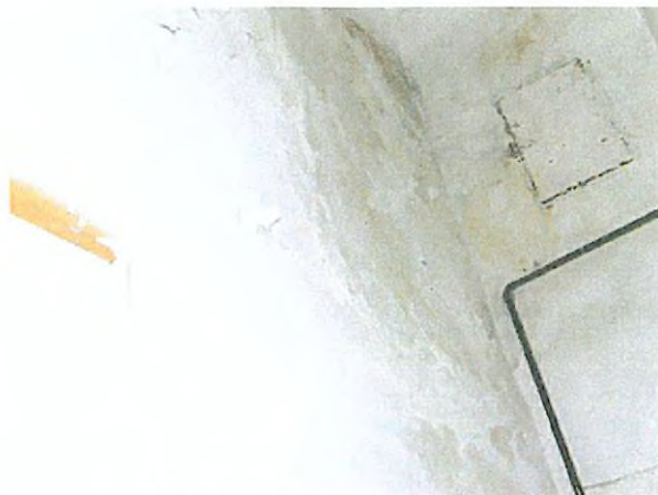
19. vizesedési nyomok a falszerkezeten
