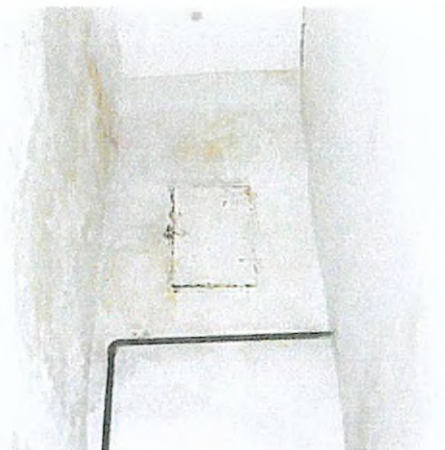
18. vizesedési nyomok a falszerkezeten
