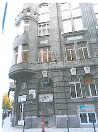
03. Kőfaragó utcai homlokzat
