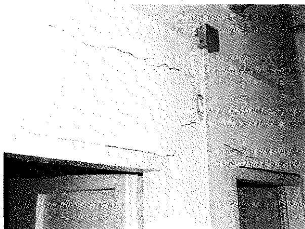
29. repedések a helyiséghatároló falszerkezeten
