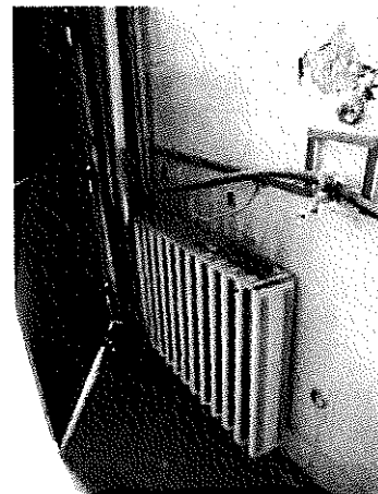
15. Radal típusú radiátor, falikút
