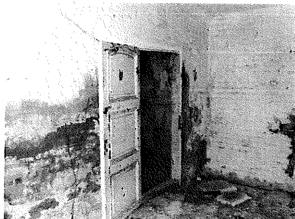
15. nyílászáró a lépcsőház felé
