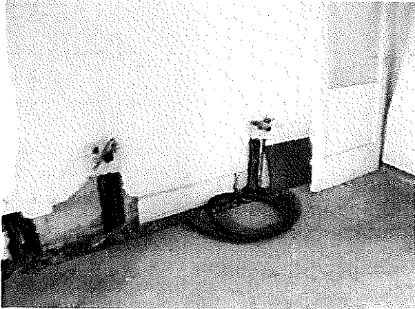
24. félbemaradt felújítási munkák
