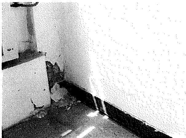
14. vakolatomlás a falszerkezeten
