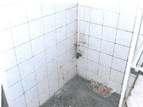
14. falszerkezet, padozat, gázvezeték
