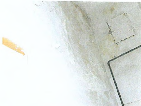
19. vizesedési nyomok a falszerkezeten
