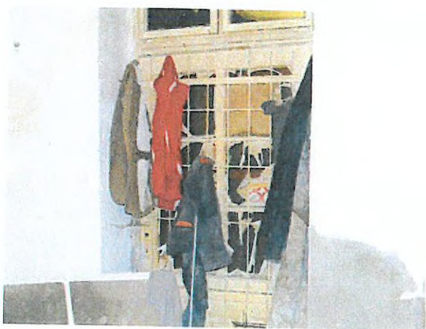
14. bejárat a belső udvar felől
