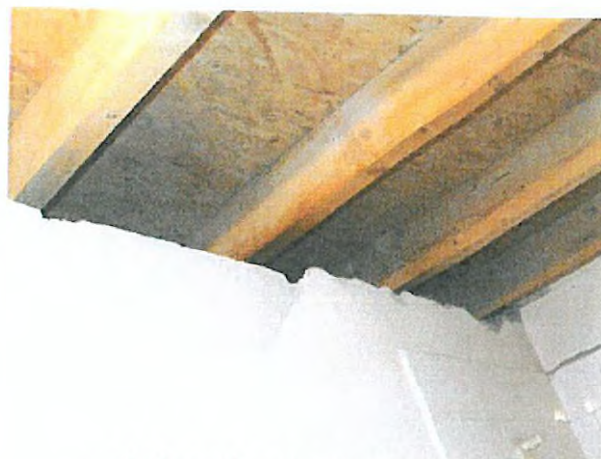
13. fa szerkezetű galéria tartószerkezete
