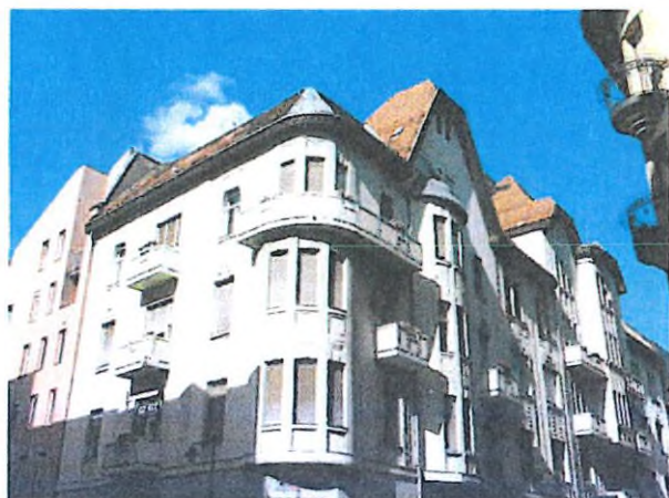
02. utcafronti homlokzat, tetőszerkezet
