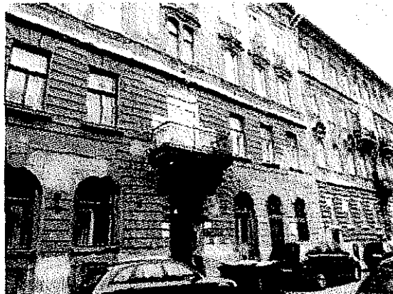
02. épület utcai homlokzata
