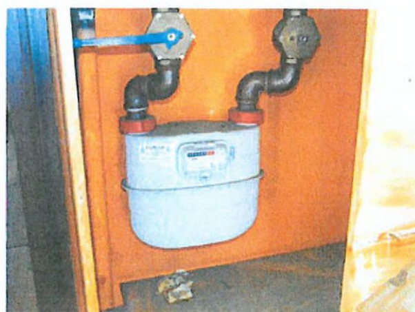
21. gázóra (rendszerrel lecsatlakoztatva)
