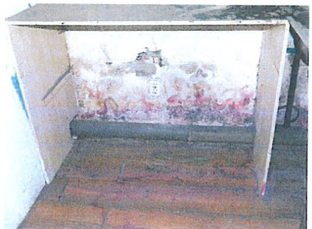
17. vizesedési nyomok a lábazati részen
