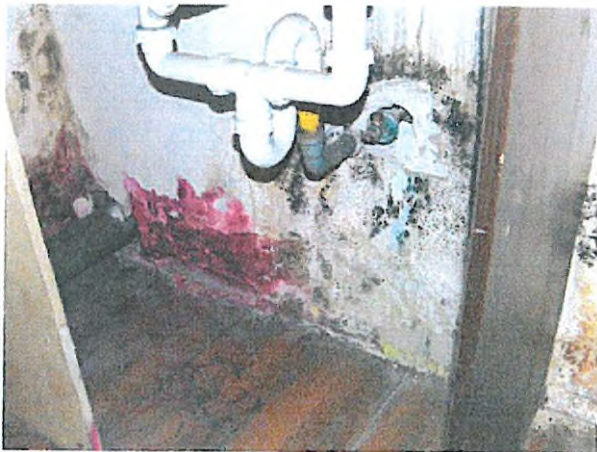
14. vízvételi lehetőség, közcsatorna csatlakozás (raktár)
