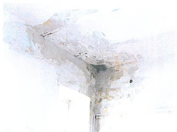
15. vizesedési nyomok a mennyezeten
