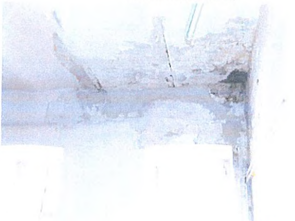
16. vizesedési nyomok a mennyezeten
