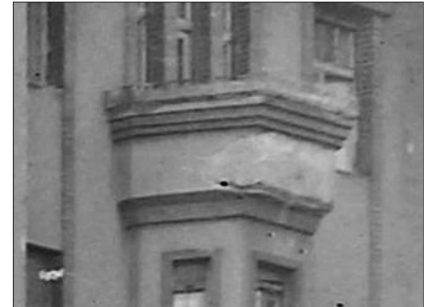
A jelenlegi állapottól jelentősen eltérő erkélymellvéd a középrizalit tetején, az 5. emeleten
