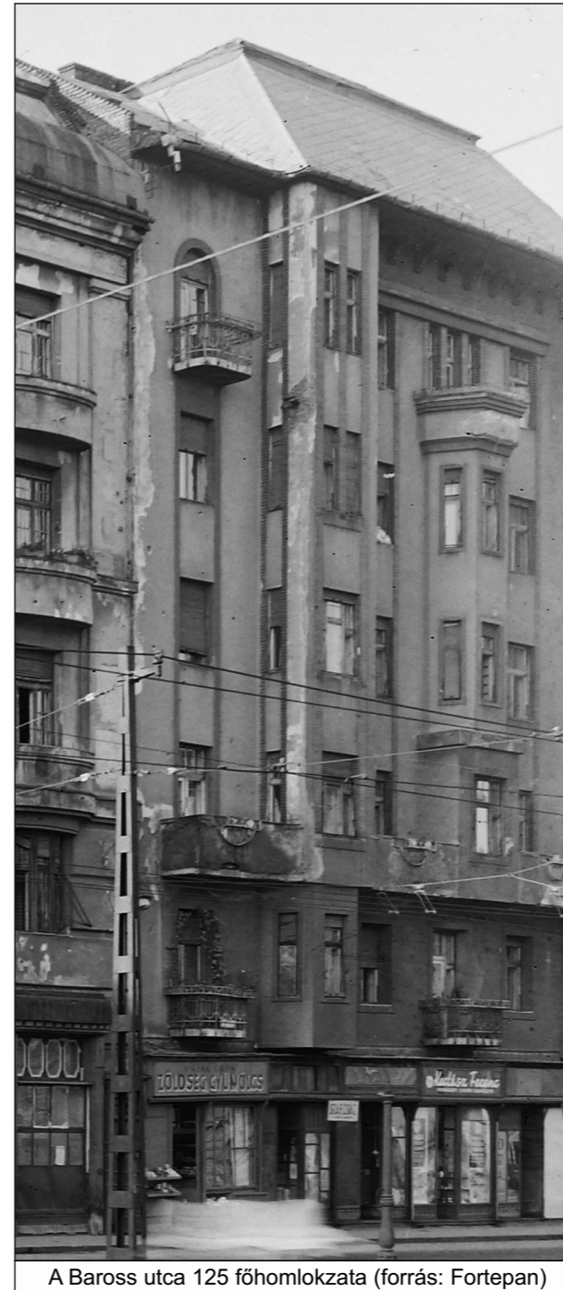
A jelenlegi állapottól jelentősen eltérő erkélymellvéd a középrizalit tetején, az 5. emeleten
