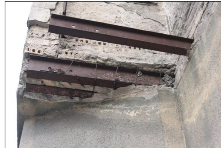
A 2. emeleten a jobb oldali rizalithoz csatlakozó terasz acélszerkezete
