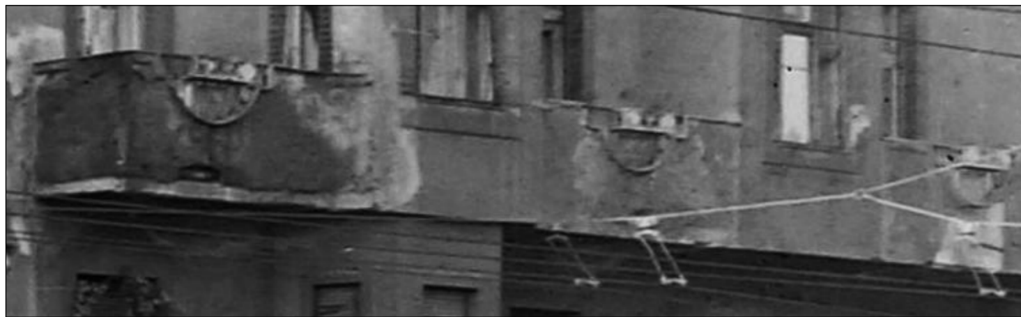
A jelenlegi állapottól jelentősen eltérő erkélymellvéd a 2. emeleten
