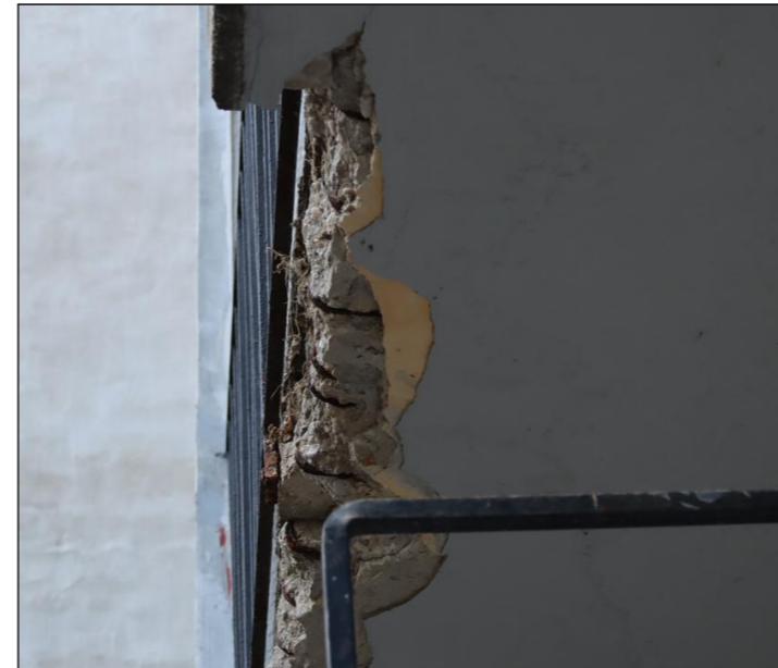
Az egyik leginkább tönkrement lemezperem a déli homlokzaton, a 3.3 lakás teraszának pereme (a 2.3 lakásból fotózva).
