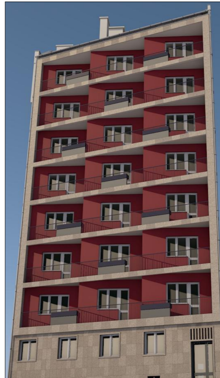
Az északi homlokzat (tervezett állapot), az eredeti helyeken kőburkolattal, erős vörös színben.
