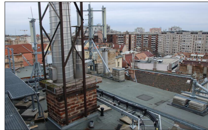
A déli homlokzatra kifutó (a 8. emeleti lakások feletti) lapostető, amit nem hőszigetelünk
