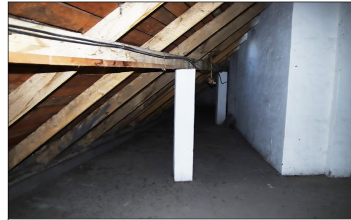
A főhomlokzat feletti padlás padlója, amit hőszigetelünk
