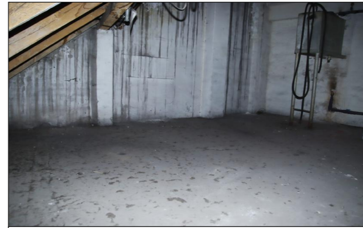
A padlás falai, melyeket hőszigetelünk (a tűzfalat külső oldalon, lakás falát a padlás felől)
