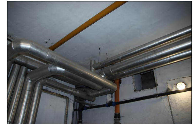
A keleti tűzfal melletti traktusban lévő szellőzőgépház és kazánház feletti pincefödém, amit hőszigetelünk
