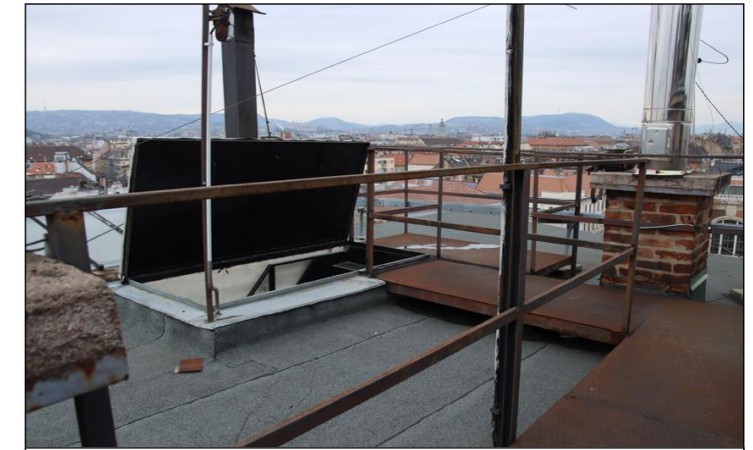
A lépcsőház feletti lapostető, amit nem hőszigetelünk
