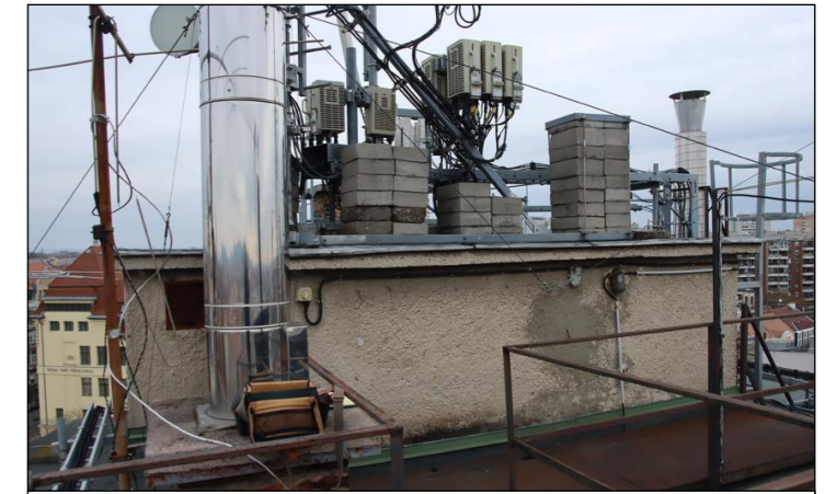
A liftgépház. A falakat hőszigeteljük, a lapostetőt nem.
