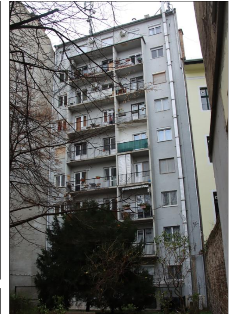
A belső (déli) homlokzat
