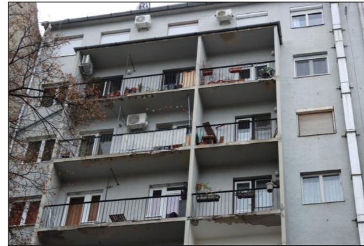
A belső (déli) homlokzat felső zónája az 5-8 emelet között
