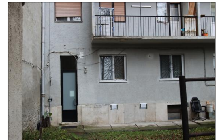
A belső (déli) homlokzat alsó zónája.
