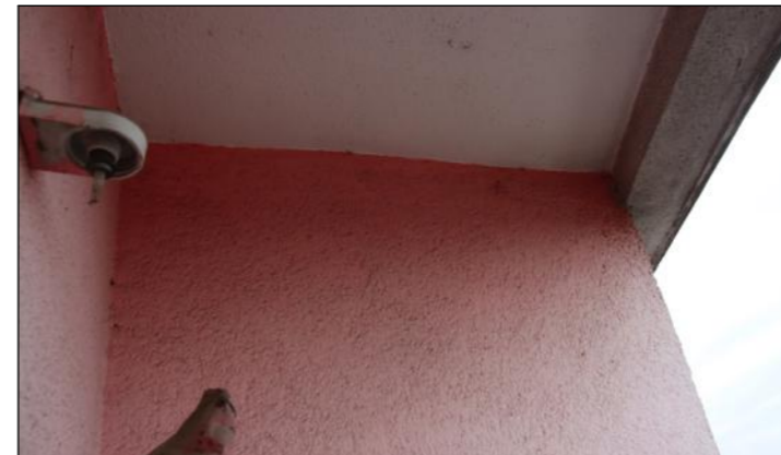
A főhomlokzat minden szinte végigmenő peremgerendája és a vékony vasbeton lemez a teraszok alatt
