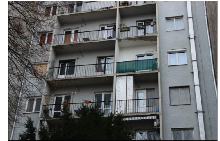
A belső (déli) homlokzat középső zónája az 3-5. emelet között
