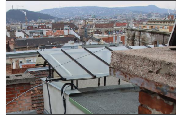
A bevilágító udvar felső lehatárolása a lépcsőházi födemből kiemelt drótüveges védőtetővel.
