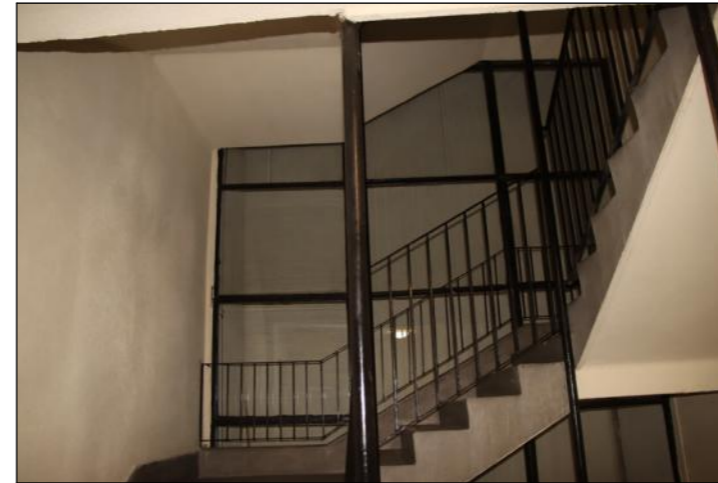
A lépcsőház és bevilágító udvar közti függőnyfal (egyszeres üvegezés, hőhidas acél szerkezet).
