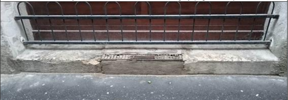
Új tömbkő fellépő, pincszellőzővel. Új szerkezet lesz. A rácsot le kell szerelni, helyette nem készül új szerkezet. Kölcsey utca, a Gutenberg tér felőli 4. tengely (zeneműbolt).
