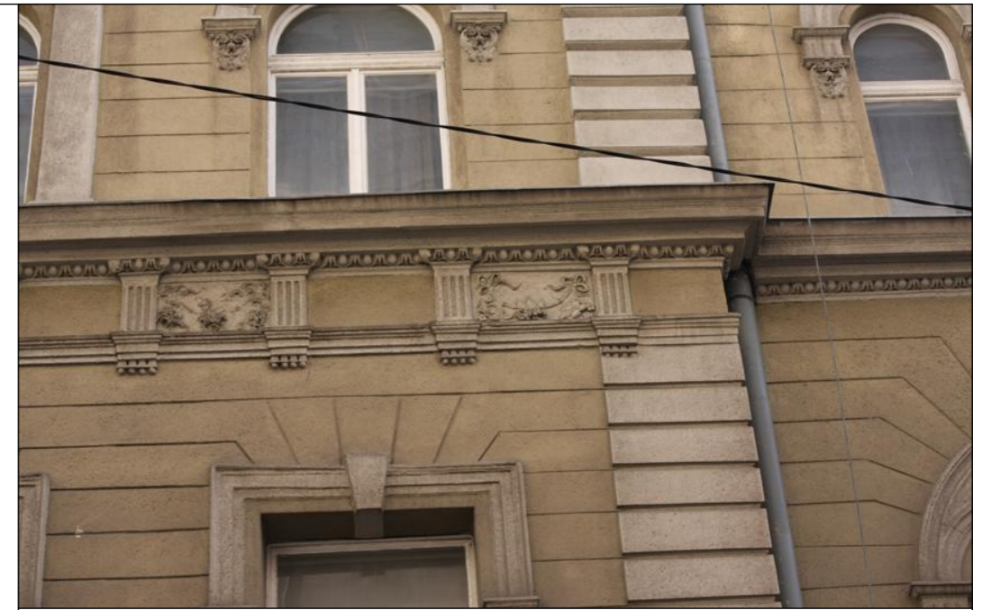
A 2. osztópárkány a Kölcsey utcai homlokzaton.
