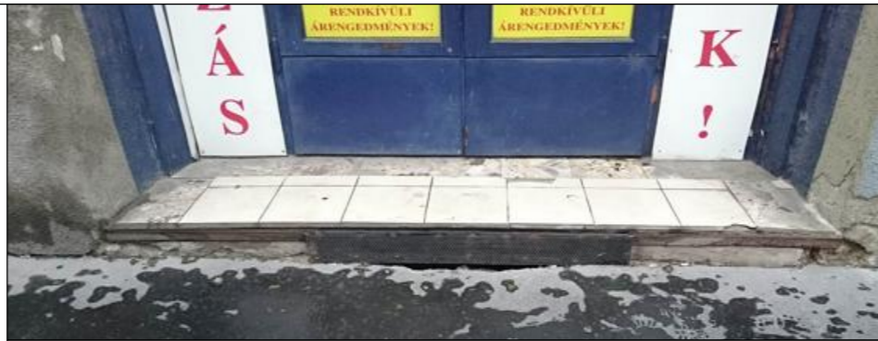
Új tömbkő fellépő pinceszellőzővel. Új szerkezet lesz. József körút, a Békési utca felőli 2. tengely (használaton kívüli üzlet).
