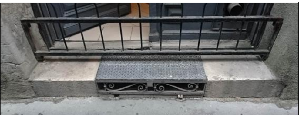
Meglévő kő fellépő pincszellőzővel. Tisztítás, polírozás. A rácsot le kell szerelni, helyette nem készül új szerkezet. Kölcsey utca, a József körút felőli 3. tengely (fogtechnika).
