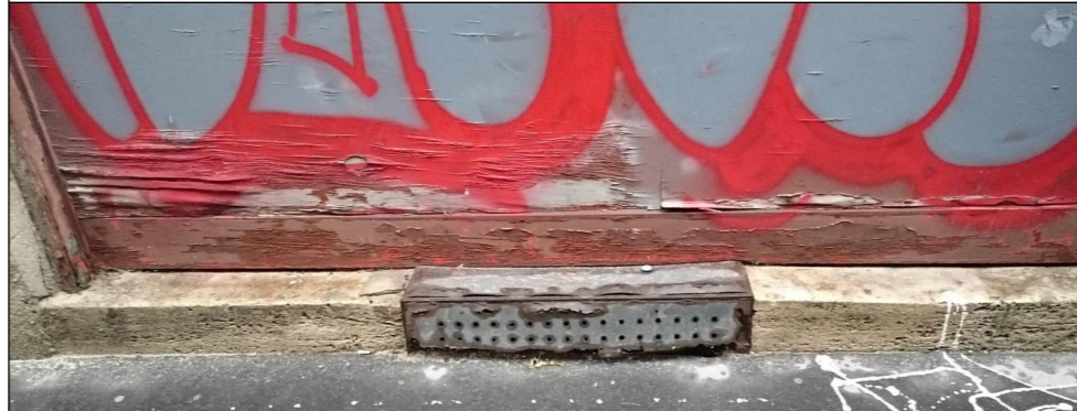
Meglévő kő fellépő pincszellőzővel. Tisztítás, polírozás.
