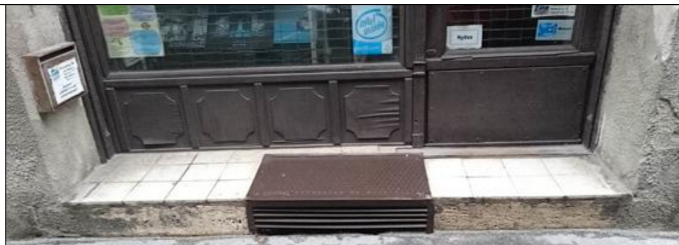
Új tömbkő fellépő, pincszellőzővel. Új szerkezet lesz.
