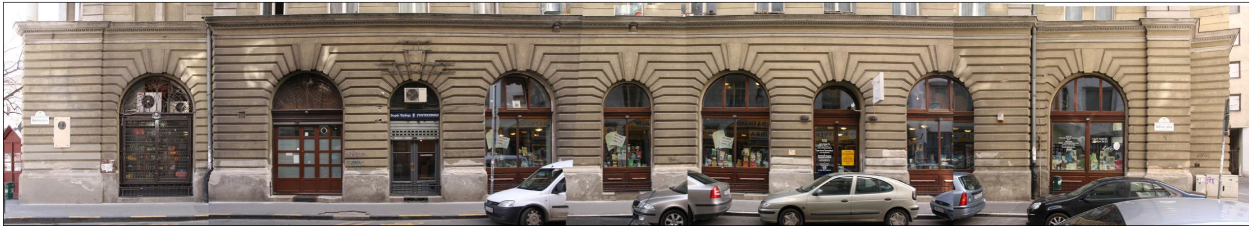
Kölcsey utca, földszinti homlokzat. Jelenlegi állapot. A montázs 2018-ban készült, de a portálok azóta nem változtak.
