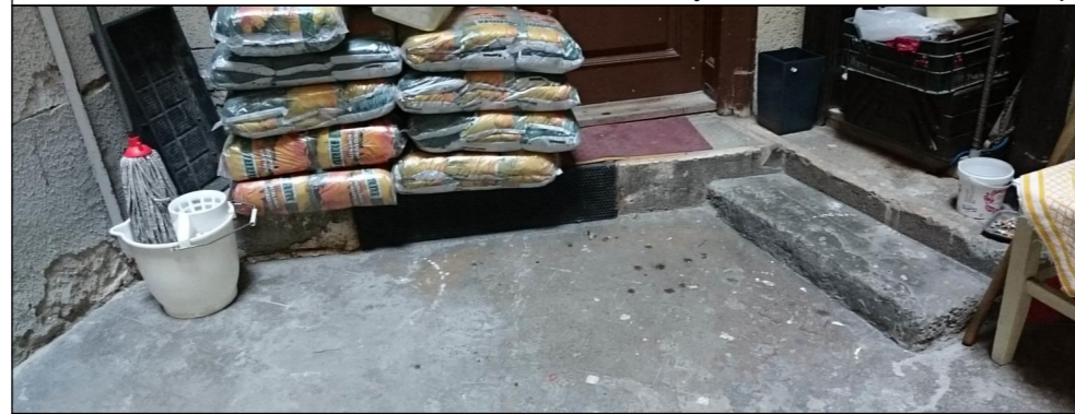
Meglévő kő fellépő pincszellőzővel. Tisztítás, polírozás. A belső udvar hátsó bejárata előtti tömbkő fellépő.
