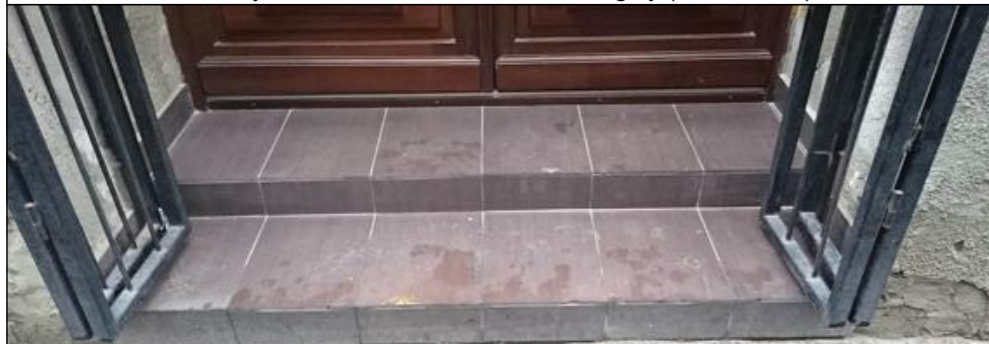
Új tömbkő fellépő. Új szerkezet lesz. A rácsot le kell szerelni, helyette nem készül új szerkezet. Kölcsey utca, a Gutenberg tér felőli 3. tengely (zeneműbolt bejárata).
