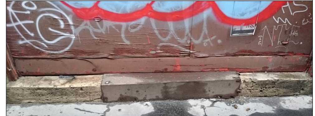
Meglévő kő fellépő pincszellőzővel. Tisztítás, polírozás.
