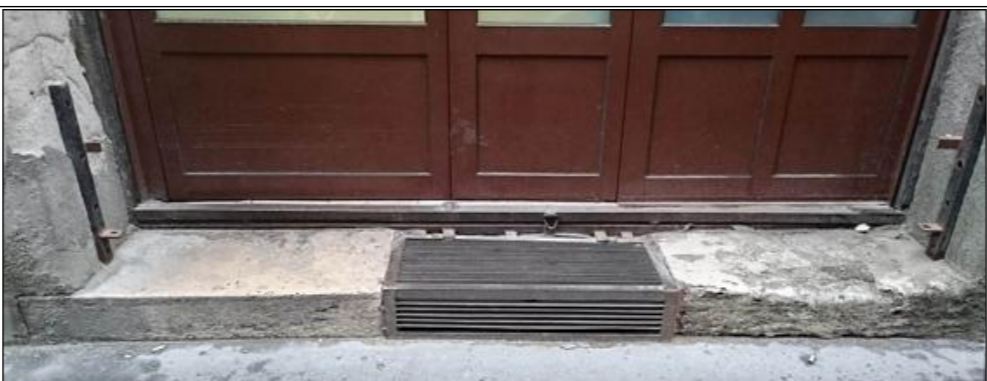
Baloldalt meglévő kő fellépő tisztítva. Pincszellőző. A jobb oldali tömbkő új. Kölcsey utca, a József körút felőli 2. tengely (görög csemege).
