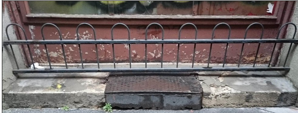
Új tömbkő fellépő, pincszellőzővel. Új szerkezet lesz. A rácsot le kell szerelni, helyette nem készül új szerkezet.
