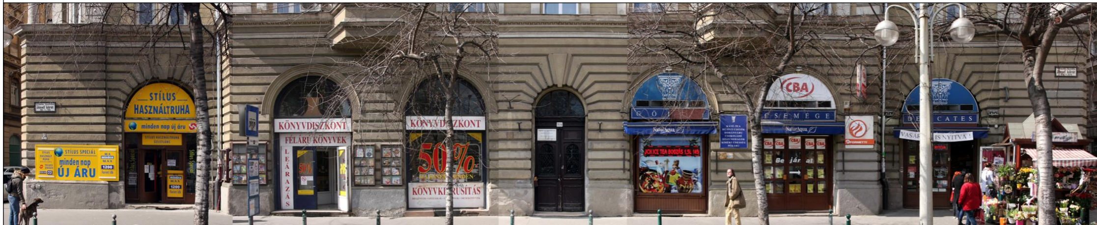
József körút, földszinti homlokzat. Jelenlegi állapot. A montázs 2018-ban készült, de a portálok azóta nem változtak. A főbejárat restaurálása megtörtént.
