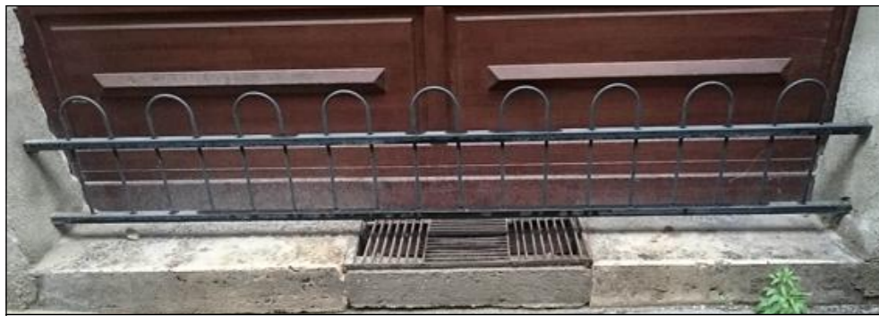
Meglévő kő fellépő pincszellőzővel. Tisztítás, polírozás, beton bontás. A rácsot le kell szerelni, helyette nem készül új szerkezet.
