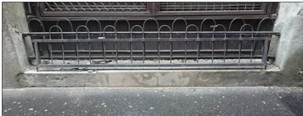
Meglévő kő fellépő, pincszellőző nélkül. A vakolatot le kell vésni, tisztítás, polírozás. A rácsot le kell szerelni, helyette nem készül új szerkezet. Kölcsey utca, a József körút felőli 1. tengely (görög csemege).
