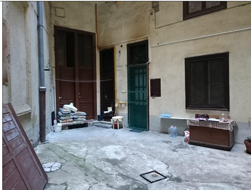
A belső udvar és a belső homlokzatok.
