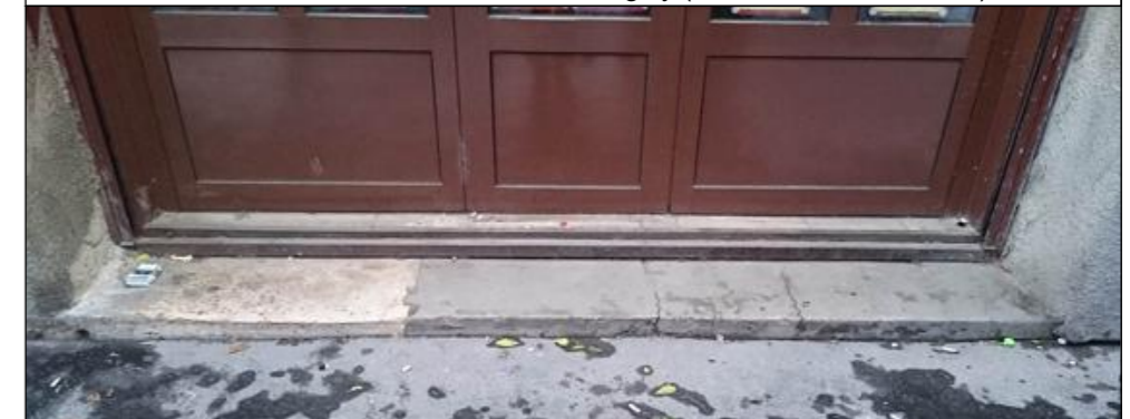
Új tömbkő fellépő pinceszellőző nélkül. Új szerkezet lesz. József körút, a Kölcsey utca felőli 2. tengely (görög csemege).
