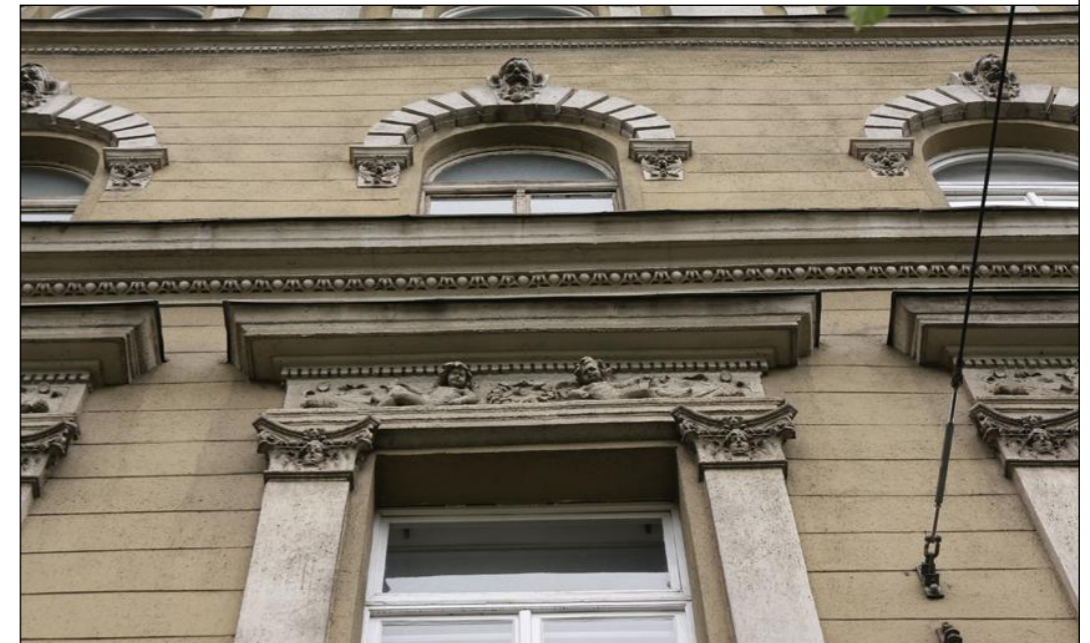
Az 1. emeleti nyíláskeretezés, szemöldökkörpárkány és a 2. osztópárkány a József körüti homlokzaton.
