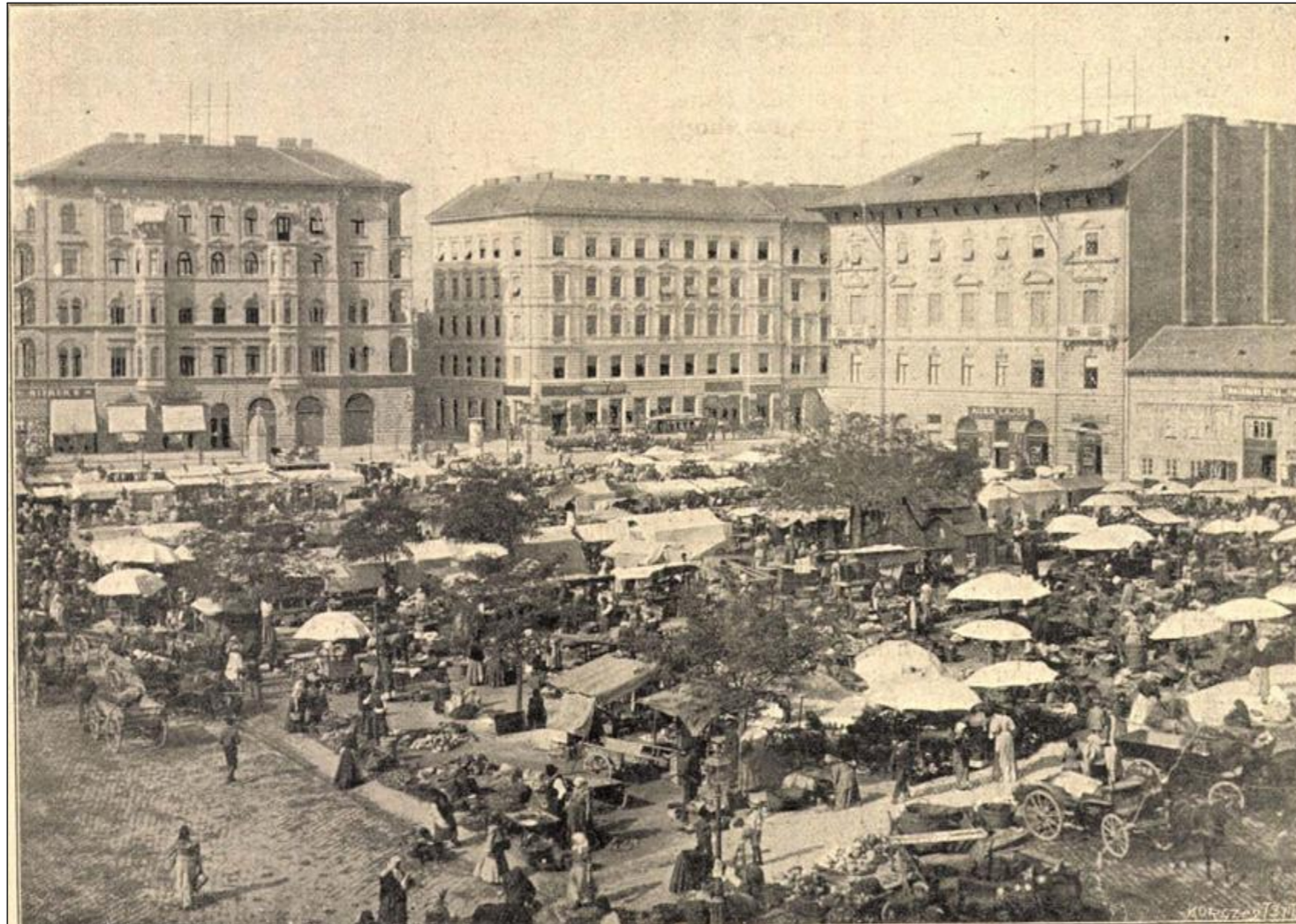
Egy 1896-ban készült fotó, amin hitelesen látható az eredeti (megépült) homlokzat. Forrás: Divald Károly fotó. Új Idők - Szépirodalmi, művészeti és társadalmi képes hetilap 2. évf. 52. sz. (1896. december 2.), 533. old.
