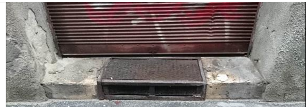
Meglévő kő fellépő pincszellőzővel. Tisztítás, polírozás, beton bontás.
