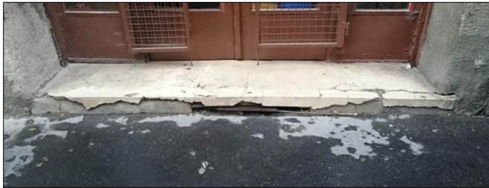
Új tömbkő fellépő pinceszellőző nélkül. Új szerkezet lesz. József körút, a Békési utca felőli 1. tengely (használaton kívüli üzlet).
