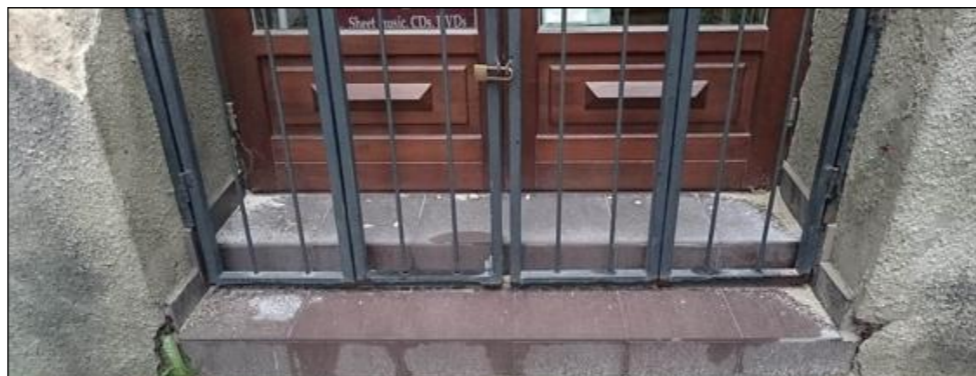
Új tömbkő fellépő. Új szerkezet lesz. Új, kovácsoltvas korlát készül. Gutenberg tér felőli tengely (kávézó).
