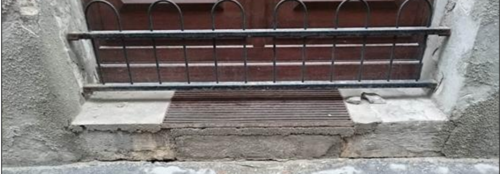
Új tömbkő fellépő, pincszellőzővel. Új szerkezet lesz. A rácsot le kell szerelni, helyette nem készül új szerkezet. Kölcsey utca, középső tengely (zeneműbolt).
