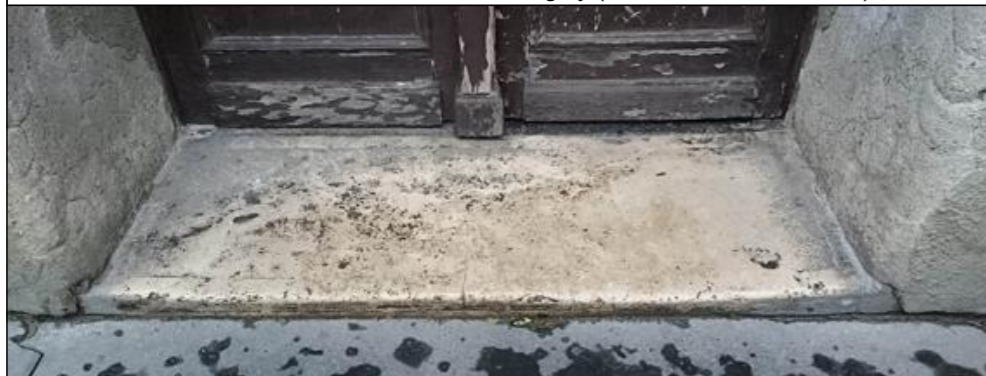
Meglévő kő fellépő pinceszellőző nélkül. Tisztítás, polírozás. József körút, a középső tengely (főbejárat).
