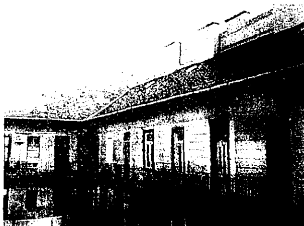
07. belső homlokzat, tető
