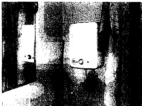
17. felső szerelésű helyi vízmelegítő
