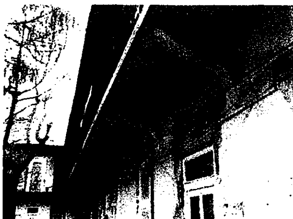
06. belső homlokzat, közlekedő folyosó
