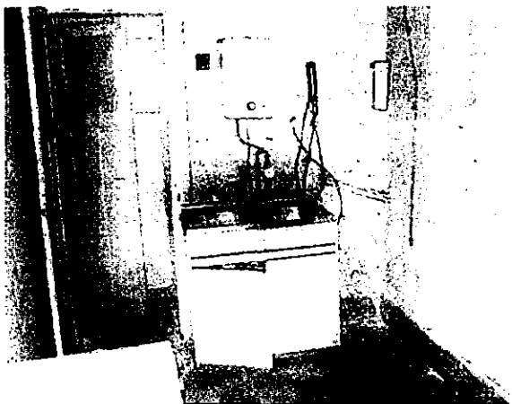
08. konyha, felső szerelésű vízmelegítő
