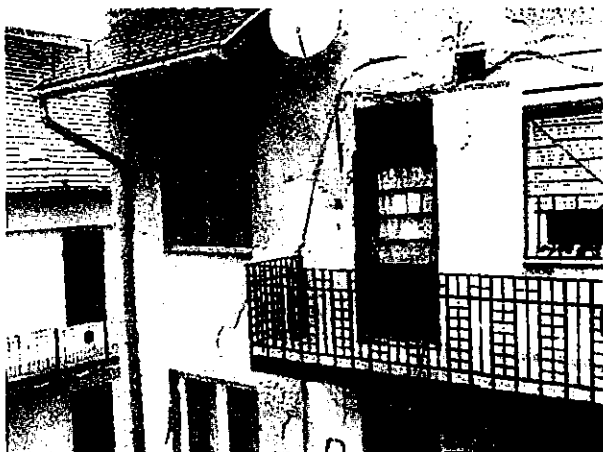
06. belső homlokzat, közlekedő folyosó
