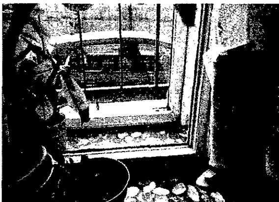
földszint 8. lakás (jellemző homlokzati nyílászáró)
