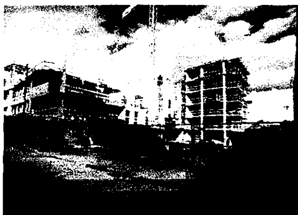
utcakép és környezet, építkezés az értékelt ingatlan környezetében
