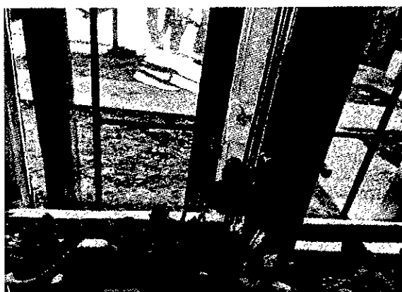
földszint 7. lakás - nyílászáró
