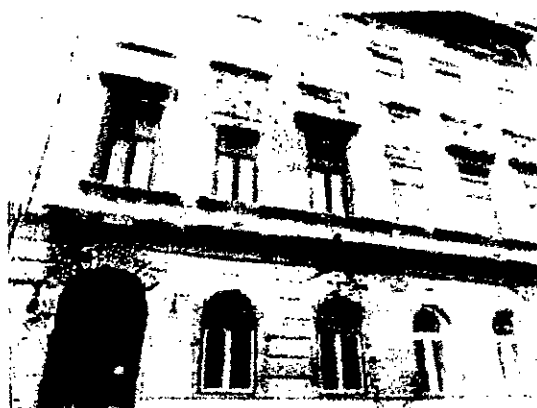
03. épület utcai homlokzata
