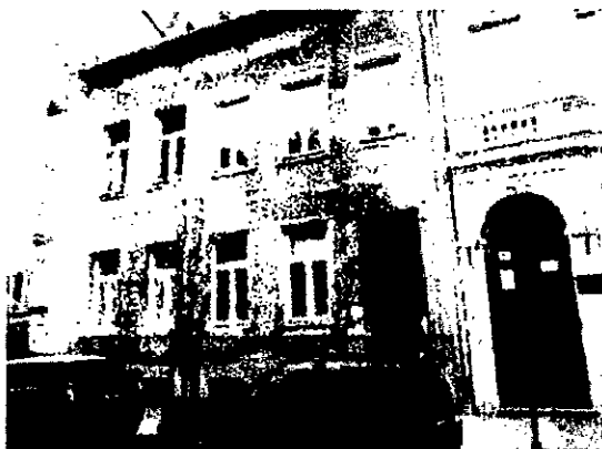
03. épület utcai homlokzata
