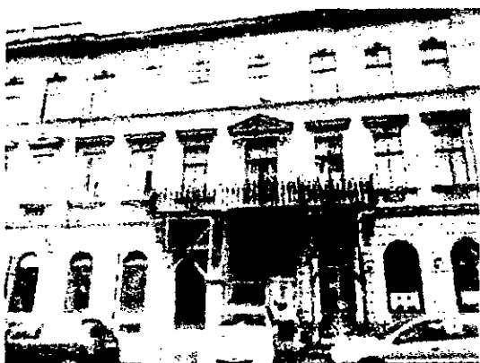
03. épület utcai homlokzata
