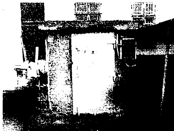
07. ingatlan bejárata a belső udvar felől
