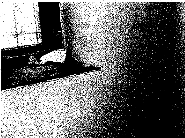
16. vizesedési nyomok a falszerkezeten
