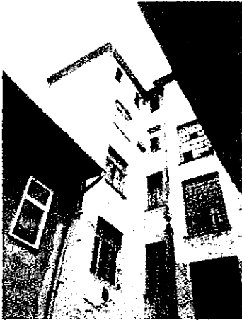
08. homlokzati vakolathullás
