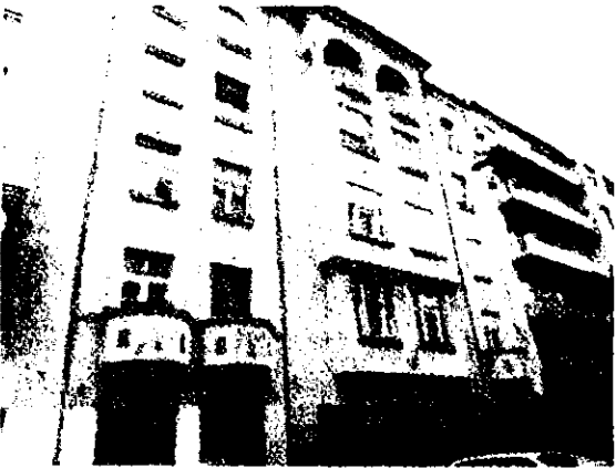
03. utcai homlokzat a Déri Miksa utca felől
