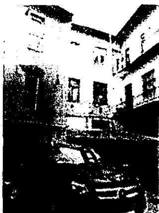
05. udvar – udvari homlokzat
