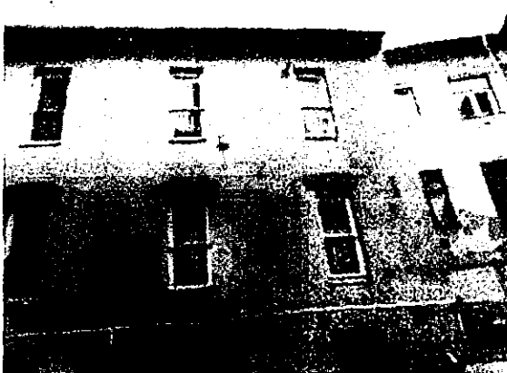
06. az értékelt épületrész homlokzata az udvarról
