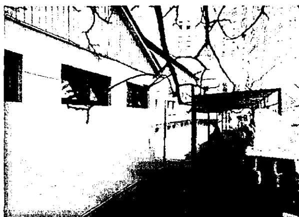
36207 hrsz.-ú ingatlan telekterülete (rajta a bontandó szociális épület)
