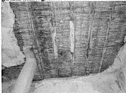
A csapos fafödém egy gerendáját aládúcolták, melynek a vége teljesen el van korhadva, az acélgerenda támaszra nem ül fel
