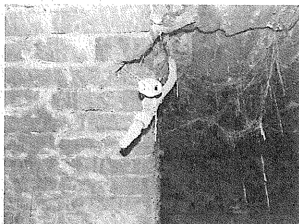
07. belső tér vízvezeték
