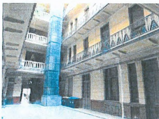
15. épület belső homlokzata
