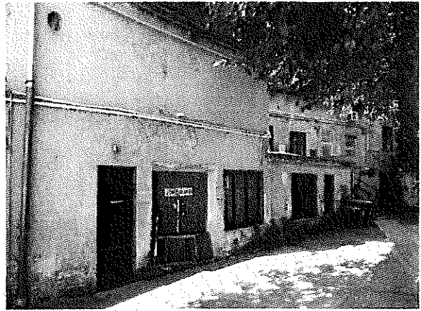
05. belső udvari homlokzat
