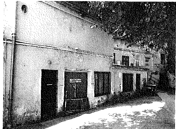
05. belső udvari homlokzat
