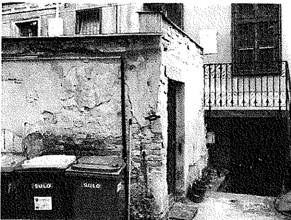
06. belső udvari homlokzat
