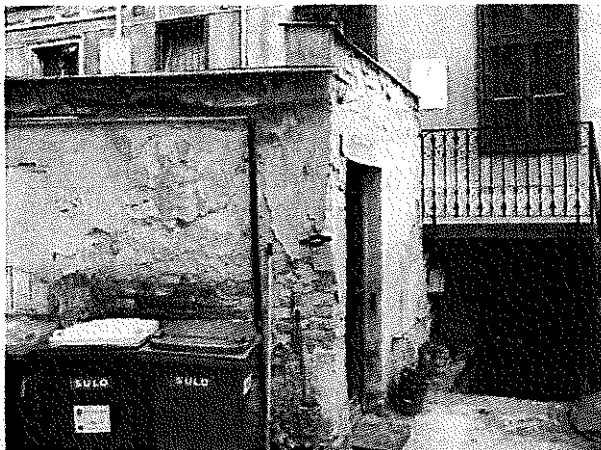
06. belső udvari homlokzat
