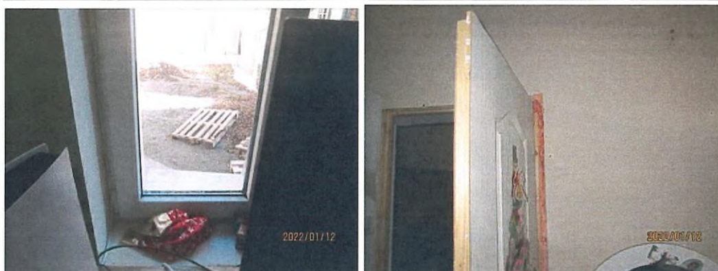
A nyílászárók elhelyezése.
