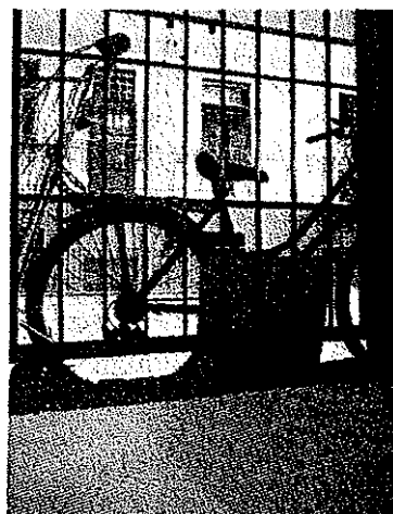
19. ráccsal védett nyílászáró
