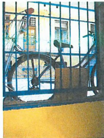
19. ráccsal védett nyílászáró
