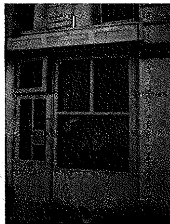
15. bejárat 2. (kívülről befalazva)
