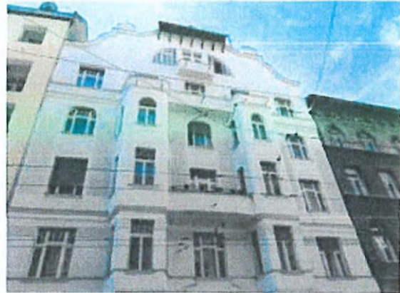
02. épület utcai homlokzata
