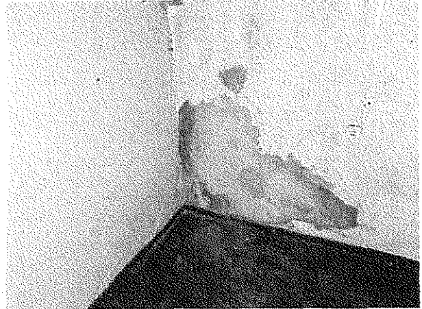
19. vakolathiba a falszerkezeten
