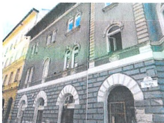
02. épület utcai homlokzata
