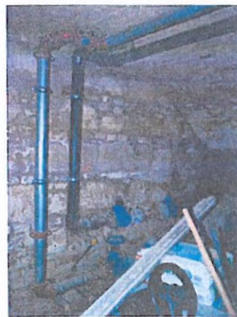
17. víz-, és tűzvíz hálózat bejövő csővezetéke
