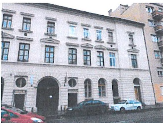
03. épület homlokzata, bejárat kapu
