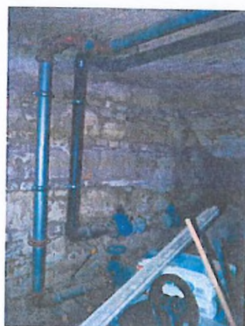
17. víz-, és tűzvíz hálózat bejövő csővezetéke
