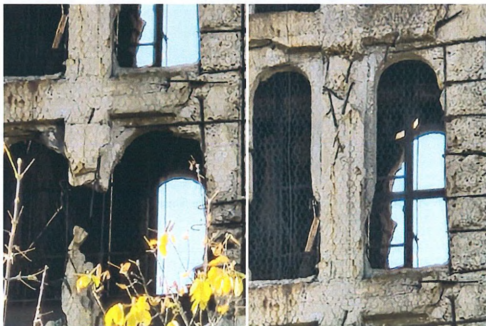
az omlásveszély miatt sűrű fonatú acél védőhálójával van bevonva.
