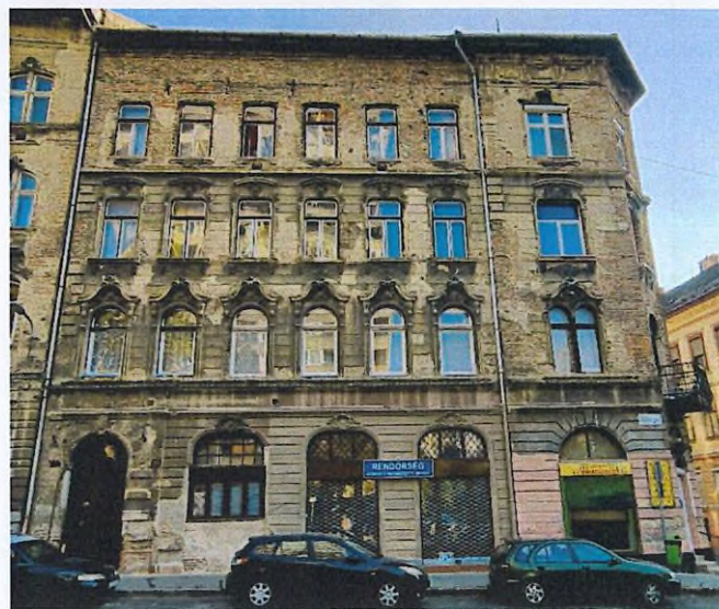
Az északi homlokzat történeti-örökségi érték
