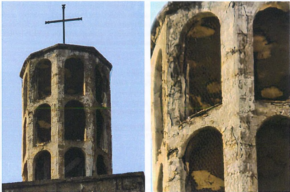
A harangokat befogadó felépítmény szintén kritikus állapotú.
