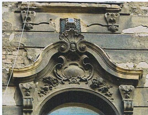
Az emeleti ablakköténybe helyezett konvektor égéstermék kivezetők idegenek a történeti homlokzaton, károsan rontják annak harmonikus örökségi összképét.
