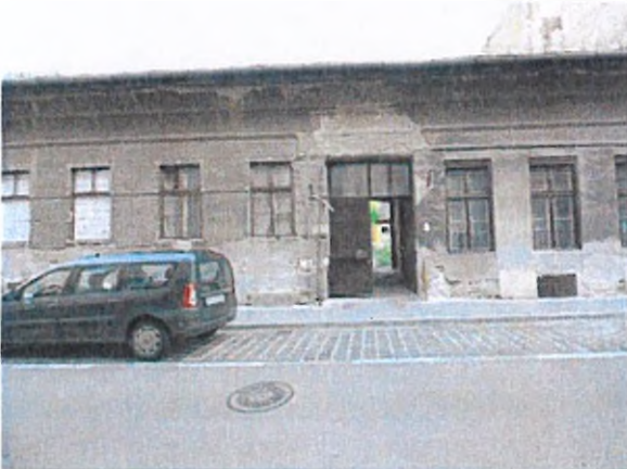
A lakóház utcai homlokzata
