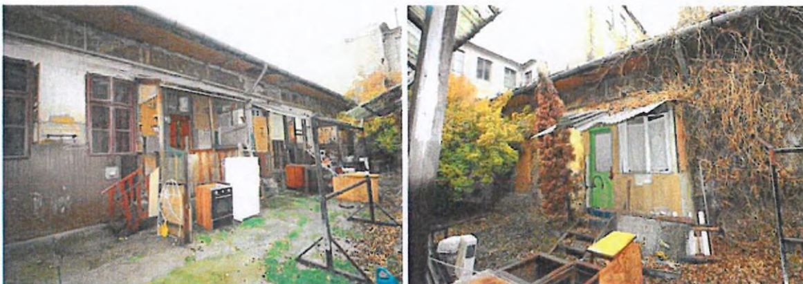
Lakóház udvari homlokzata
