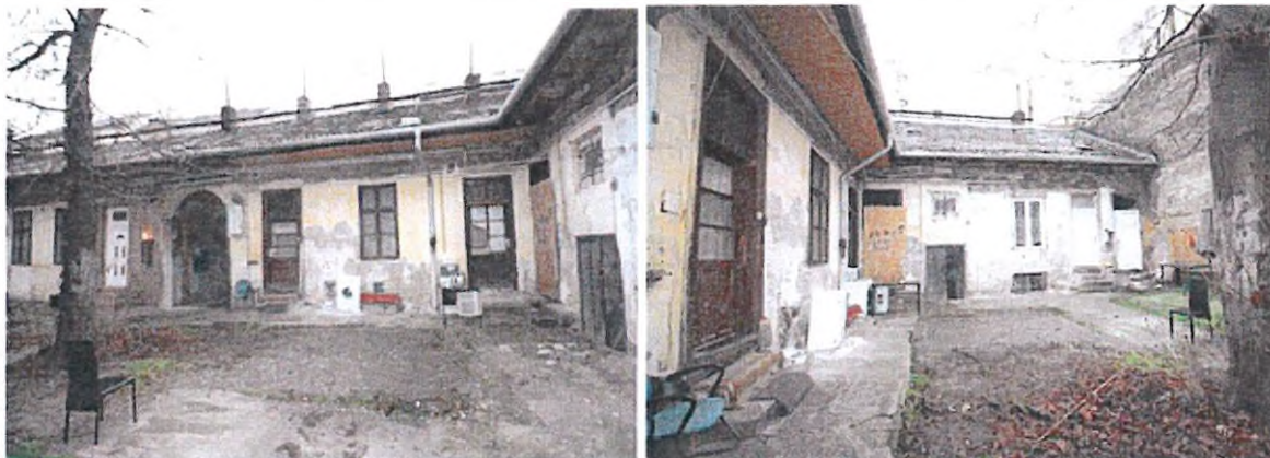
Lakóház udvari homlokzata
