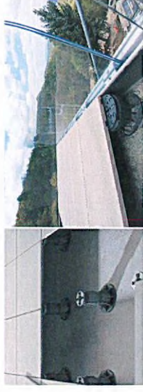
55-56. ábra - Állítható magasságú alapok, járólaphoz és fához
