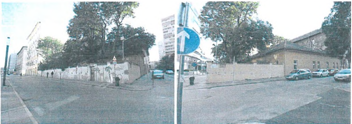
Az óvoda utcai homlokzata
