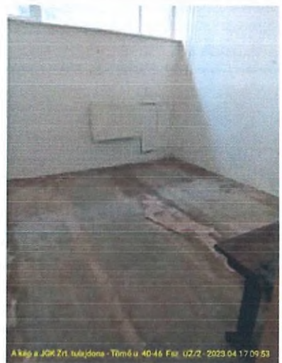
A kép a JGK Zrt. tulajdona - Tömő u. 40-46. Faz. UZ/2 - 2023.04.17.09.53
