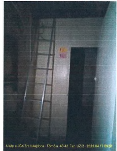
A kép a JGK Zrt. tulajdona - Tömő u. 40-46. Faz. UZ/2 - 2023.04.17.09.51
